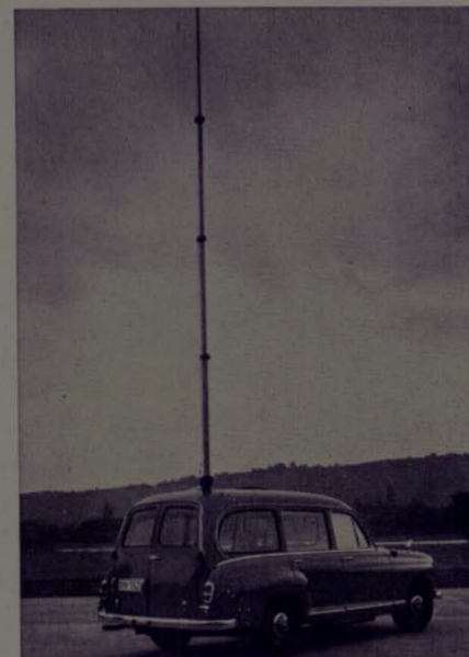
Mit dem Meßwagen wurden unter anderem die umfangreichen Außenversuche für die Prebluffsirene durchgeführt, die zur Klärung der Ausbreitung der Schallwellen in Stadt- und Landgebieten dringend notwendig waren.
