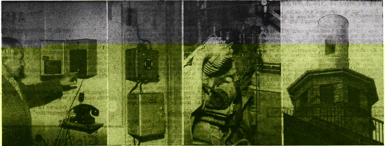
Sirenen über Gießen, V. l. n. r.: Der Knopf für den örtlich auszulösenden Alarm. — Empfangsanlage für den Alarm von Usingen. — Kompressoranlage zur Betätigung der Sirene. — Die Sirene auf der Goetheschule.
